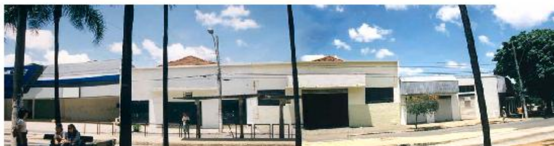
Casa térrea - antes
